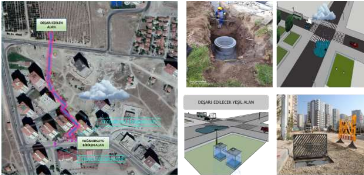
Şekil 6. KASKİ çökertme baca uygulaması
