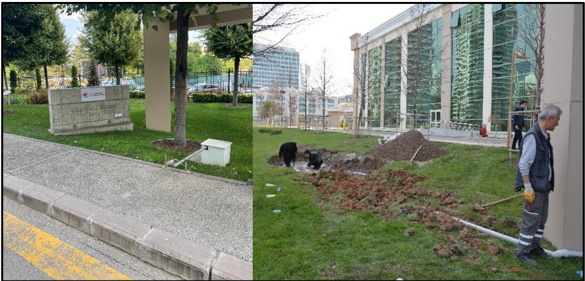
Şekil 9 Geçirimli beton ve drenaj borusu uygulaması (Orijinal, 2022-2018)
