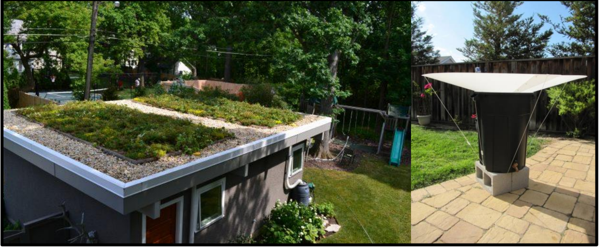
Şekil 1 Yeşil çatı ve yağmur tabağı uygulaması (Stone, 2017) ( https://tr.pinterest.com/pin/rainsaucers-an-open-letter-to-the-residents-of-flint--462463455482076677/ )
